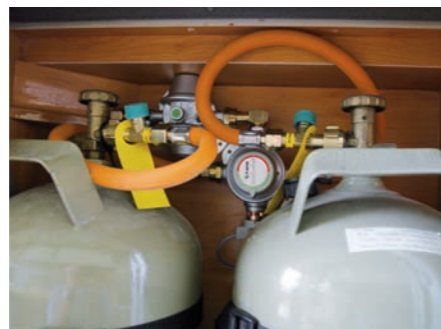
Gasregler-Anlage Truma DuoComfort. Mehrgewicht: 1.2 kg
